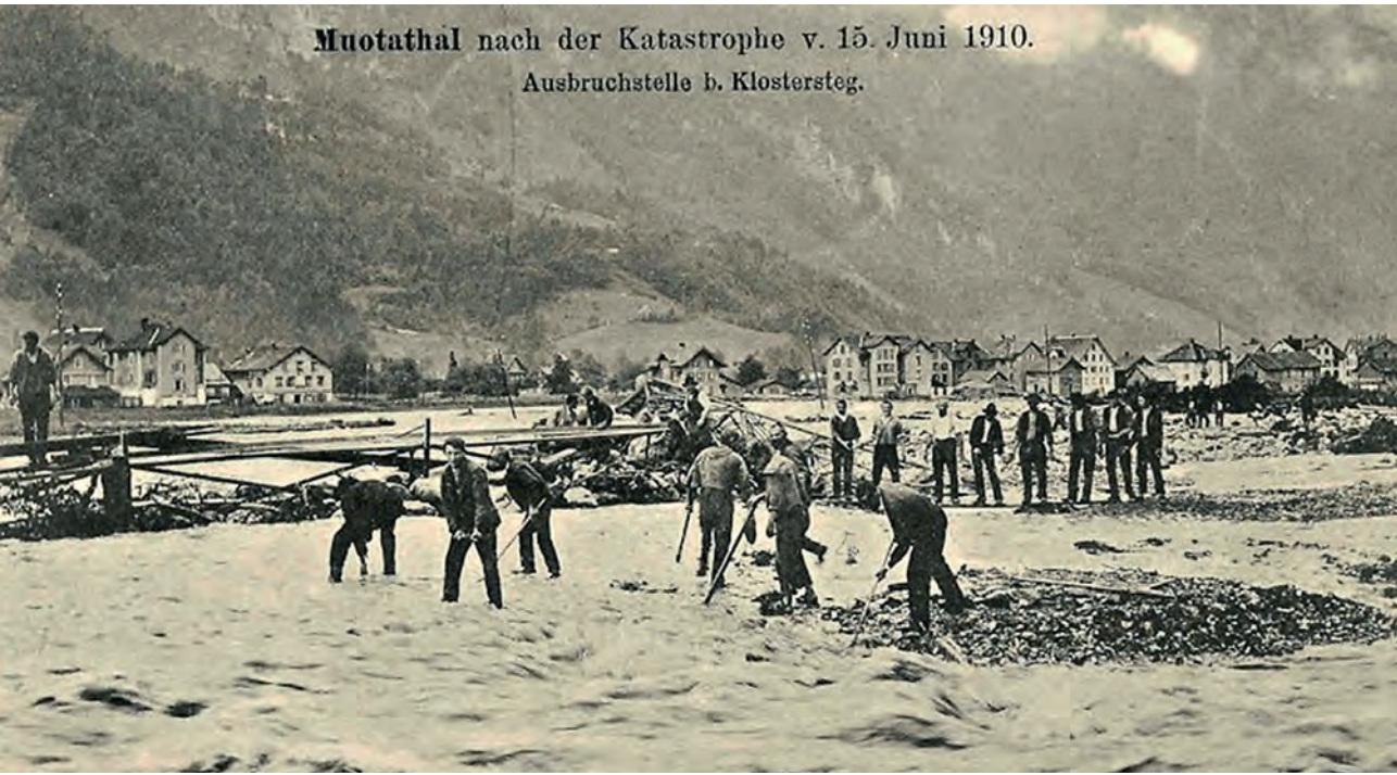
Abb. 6: Arbeiten beim Klostersteg in Muotathal unmittelbar nach der Überschwemmung vom 15. Juni 1910.
